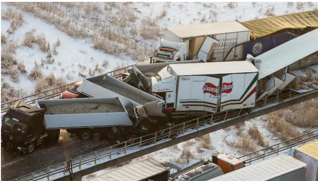
Kraftiga broräcket på E4 Tranarpsbron höll under masskrocken år 2013 med 40 tunga lastbilar
